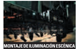
MONTAJE DE ILUMINACIÓN ESCÉNICA
