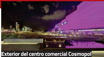
Exterior del centro comercial Cosmopol
