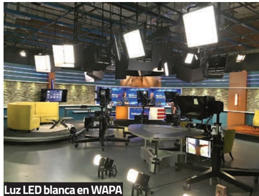
Luminarias en acción en Guatemala
